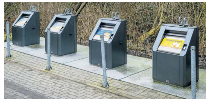
Über der Erde sieht man – wie hier am Sukoring in Suchsdorf – nur die Einwurfsäulen. Die eigentlichen Müllcontainer befinden sich unter der Erde.
