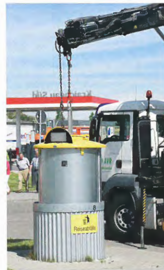
Der Austausch des Halbunterflur-Systems „GT-One“ (hier in Kraichgau Süd) kann mittels LKW-Kran zügig vorgenommen werden.
